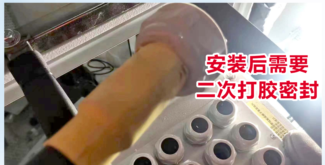
传统花瓣结构无法满足大线鼻子线电缆的可靠密封
